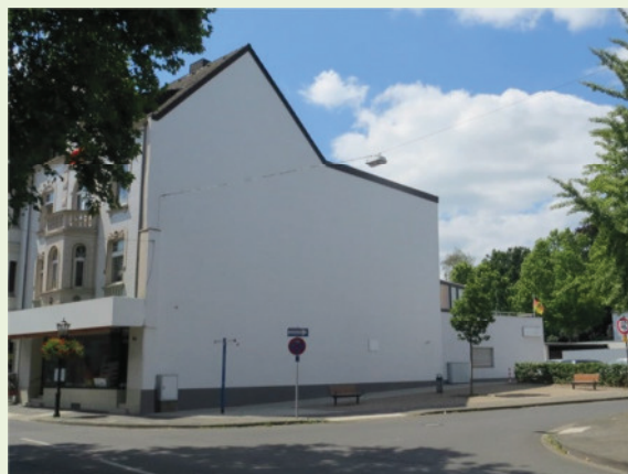
Plätzchen mit sanierter Giebelwand
